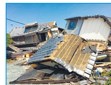
倒壊した建築物（益城町）
