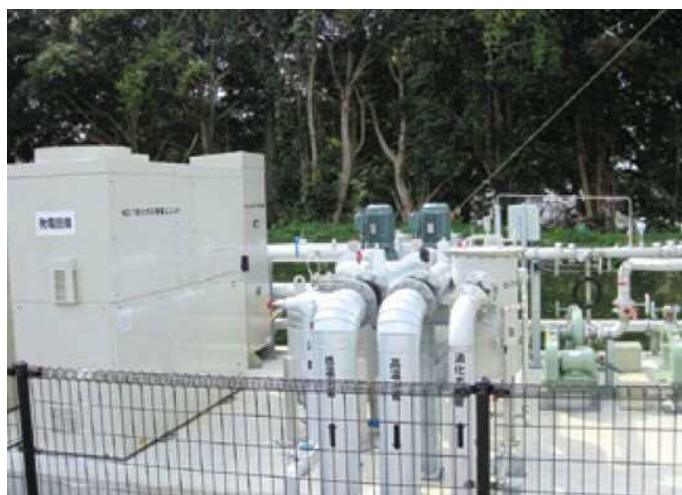
おでい はっこう 汚泥を発酵した時に発生する消化ガスを燃料とした 発電施設（大村浄水管理センター）
