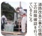
道路改良工事の仮橋工の除障確認を行う様子
