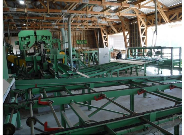
新たな製材工場
