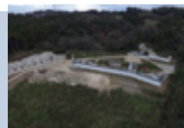
立岩地区地すべり対策工事 (排水トンネル工)
