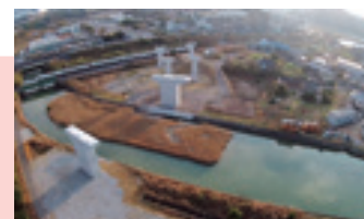
島原道路（諫早 IC 橋）
