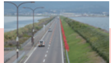
堤防道路（雲仙多良シーライン）
