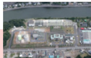
大村湾南部浄化センター
