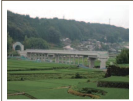
第1本明トンネル外1箇所他 本野高架橋 (H27.7撮影)
