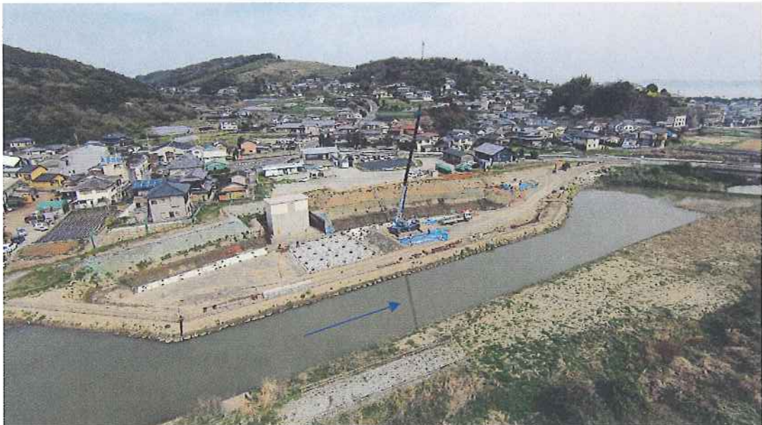
江ノ浦川河川改修工事（潮止堰施工状況）
