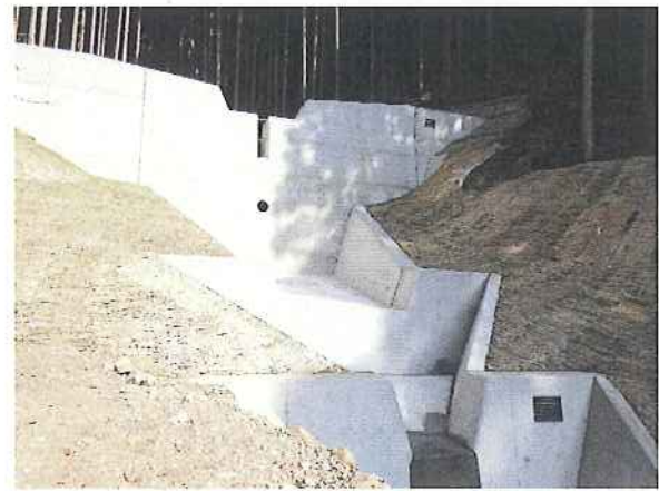
木場地区奥地保安林保全緊急対策工事 (谷止工・流路工)
