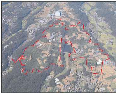
○整備前の全景〔H22年9月撮影〕
