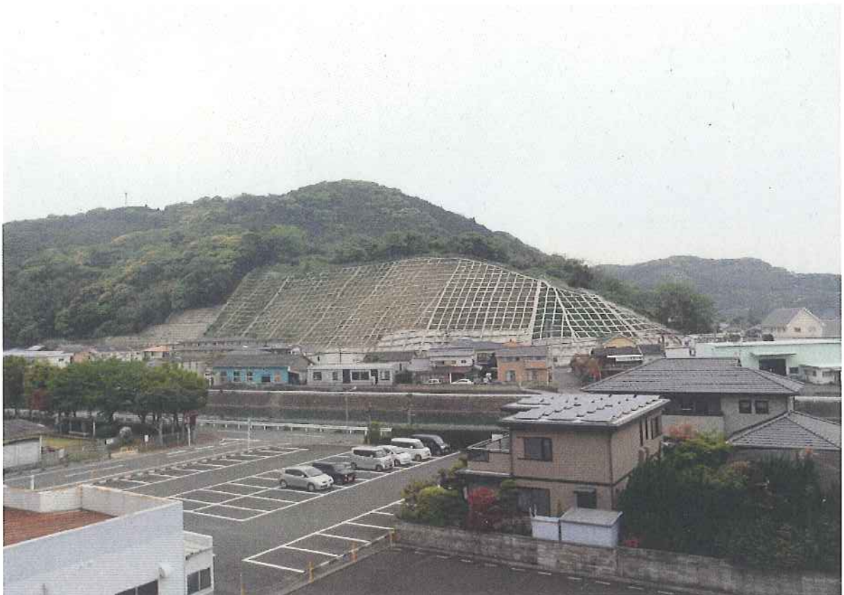
囲地区急傾斜地崩壊対策事業
