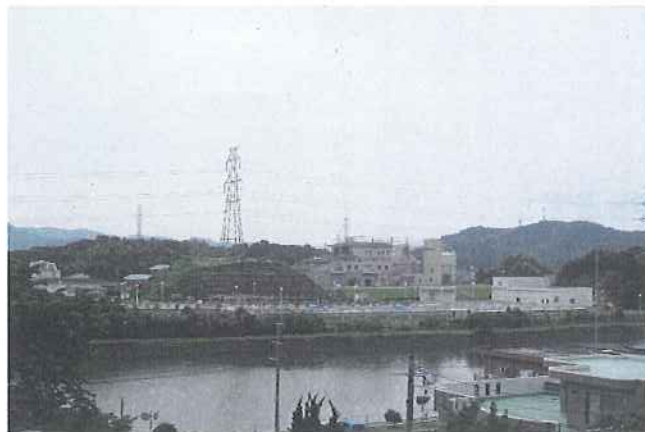
大村湾南部浄化センター
