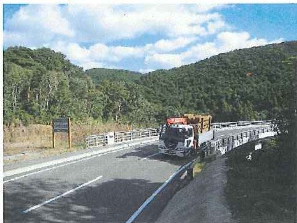
森林基幹道西彼杵半島線での間伐材運送状況
