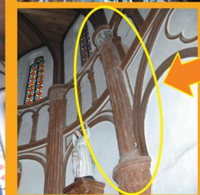
左の写真では木の柱があるように見えますが、実は「しっくい」（壁の材料）で造った飾りなのです！
