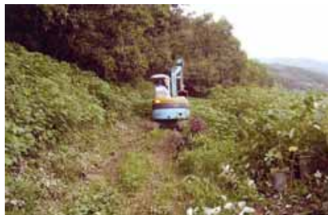
WM柵設置ルートをショベルカーで地ならし
