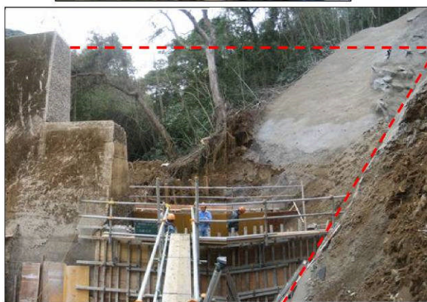
写真-4.3 打設状況
