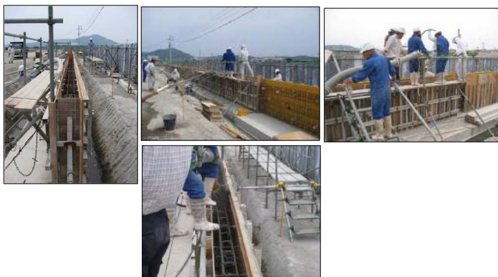
写真-4.2 打設状況
