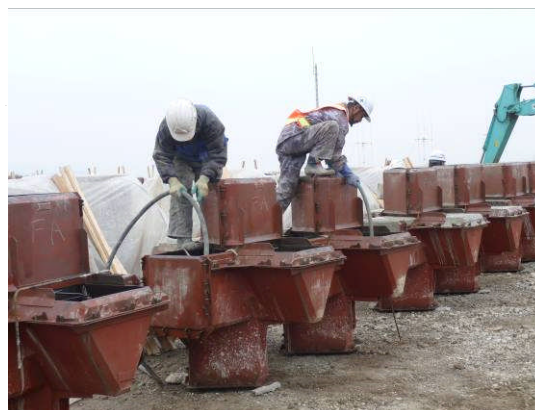
写真-4.4 打設状況
