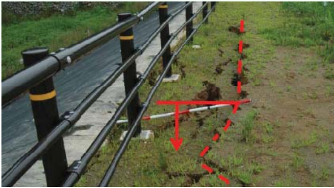
・貯水池内の亀裂や陥没の有無を確認
