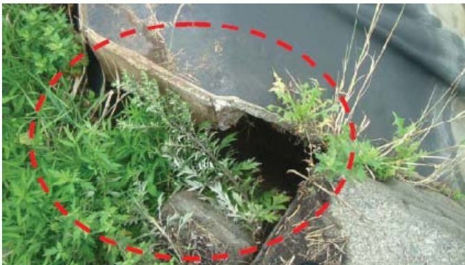
・貯水池内の構造物との接合部において陥没、空洞化の有無を確認
