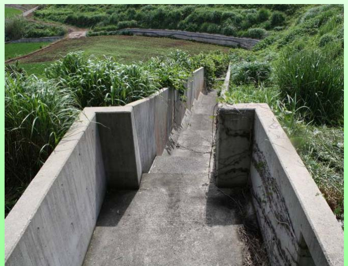
【洪水吐放水路(下流水路)】
