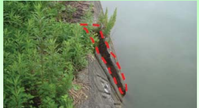
・ブロック積みとのズレや張りコンクリートの隙間の有無を確認
