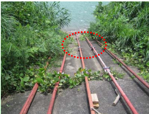
⑤斜樋の破損(スピンドル挫屈)
