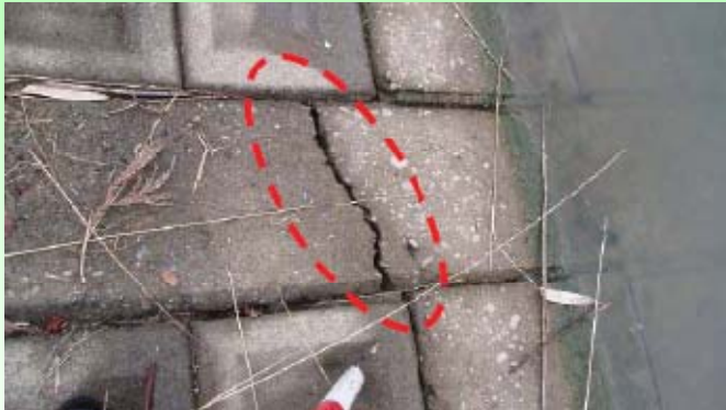
・張ブロックの亀裂や剥離の有無を確認
