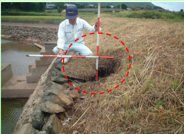
・堤体とコンクリート構造物との接合部で陥没の有無を確認
