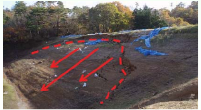
・貯水池内の法面の亀裂や沈下の有無を確認
