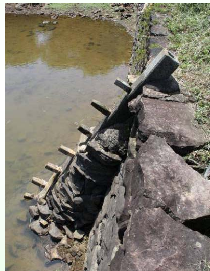
【斜樋(木栓タイプ)】
