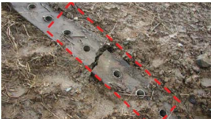
・斜樋の破損、通水障害の有無を確認
