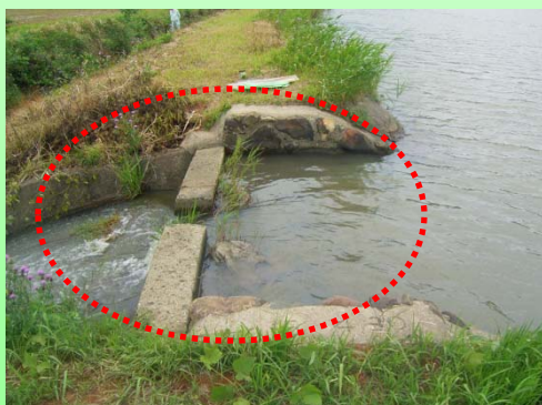
⑦洪水吐の堰上げ
