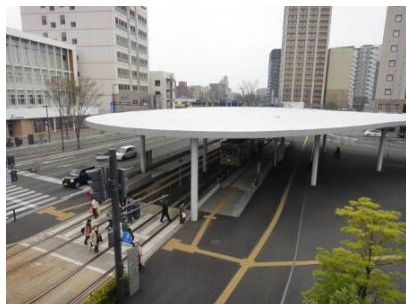
▲電停のシェルターの例(熊本駅市電) 熊本駅のシンボリックで大きなシェルターは、電停待合スペースも覆っており、利用者はゆっくりと待つことができるように配慮されています。
