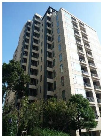
▲ 建物外壁の分節の例 (東京都千代田区・内藤廣氏(設計)) 外壁の凹凸と壁面や窓部の色彩の使い分けによって高層マンションの威圧感を軽減しています。
