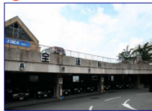
公用車車庫(昭和55年建設)
