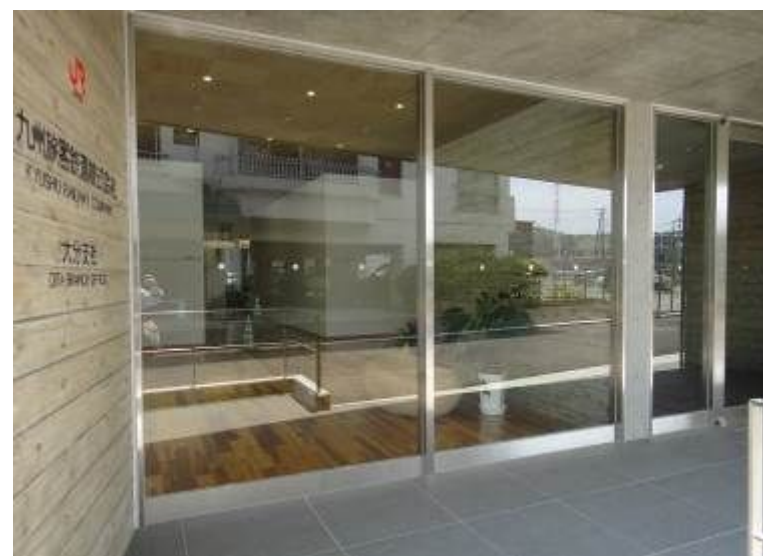
▲ 高架下利用による JR 九州大分支社(杉型枠によるコンクリート壁面)
