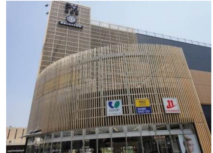
▲ 駅前商業施設(外壁に地場産杉材を用いている)
