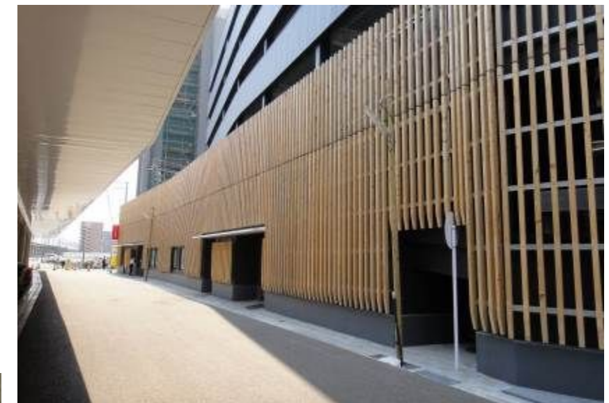
▲ 駅前商業施設・立体駐車場(低層部外壁に杉材を活用し一体感を形成している)
