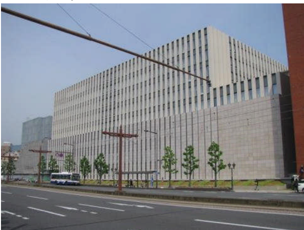
《新市民病院全景》
