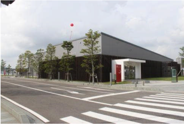
《松が枝第2ターミナル全景（山側から）》
