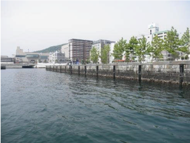
《元船物揚場全景（海側から）》
