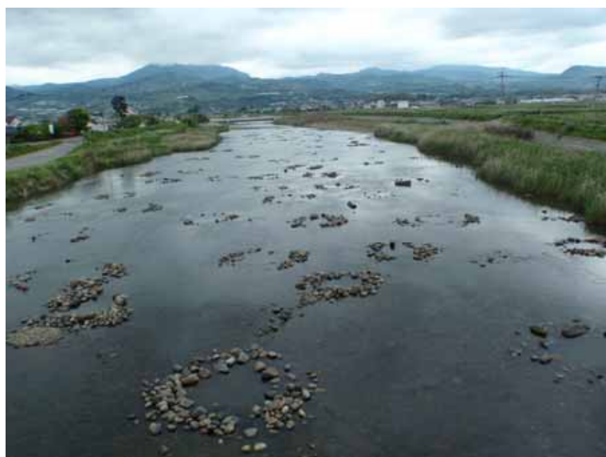
郡川・郡大橋上流(護岸・堰工事実施箇所)
