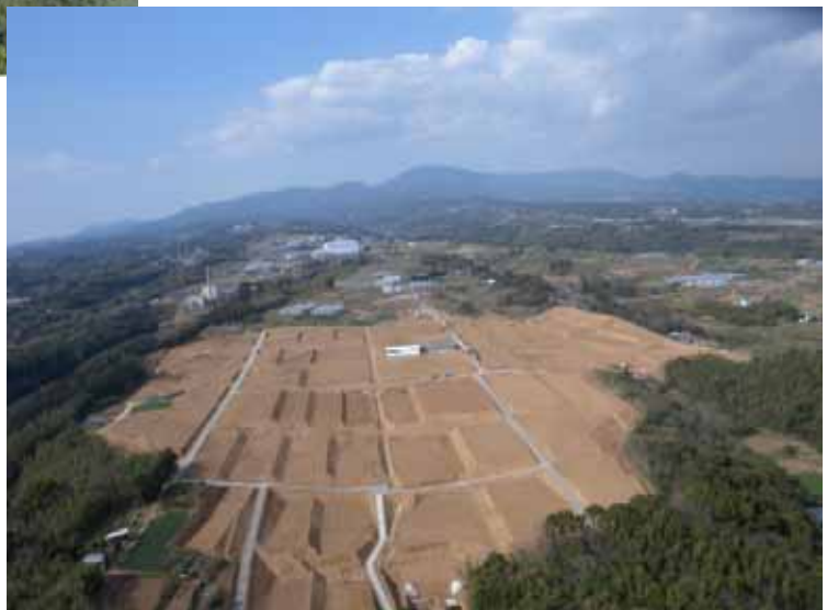
整備後（H23年3月撮影）
