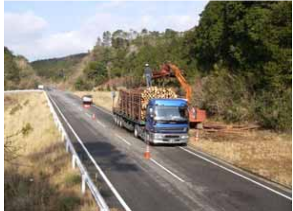
森林基幹道西彼杵半島線での間伐材搬出状況
