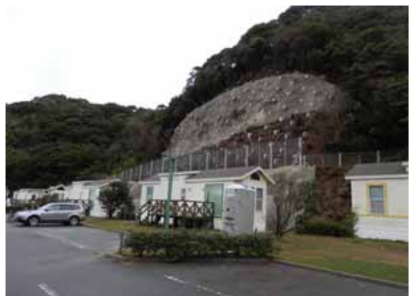
本郷今泊地区予防治山工事 (地山補強土工・土留工)
