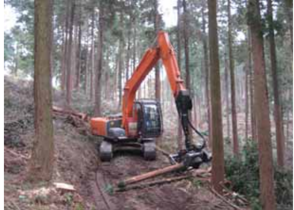
プロセッサによる間伐材の採材作業
