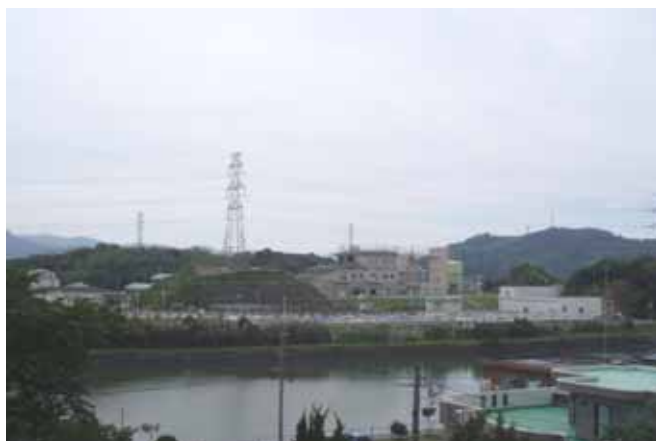
大村湾南部浄化センター
