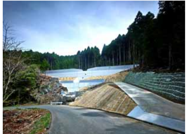
大山地区奥地保安林保全緊急対策工事 (谷止工・護岸工)
