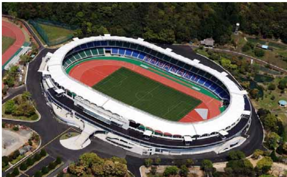
国体整備を行う県立総合運動公園(写真中央の陸上競技場は、平成25年3月供用開始)
