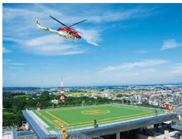
屋上ヘリポートの事例
