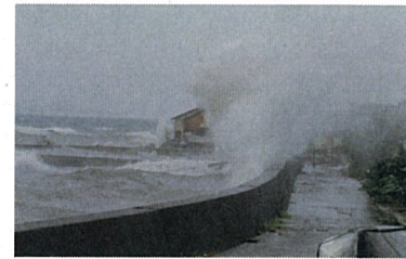
高潮被災状況
