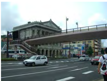
写真-4 〈旧香港上海銀行長崎支店記念館前〉 歩道橋が撤去される前
