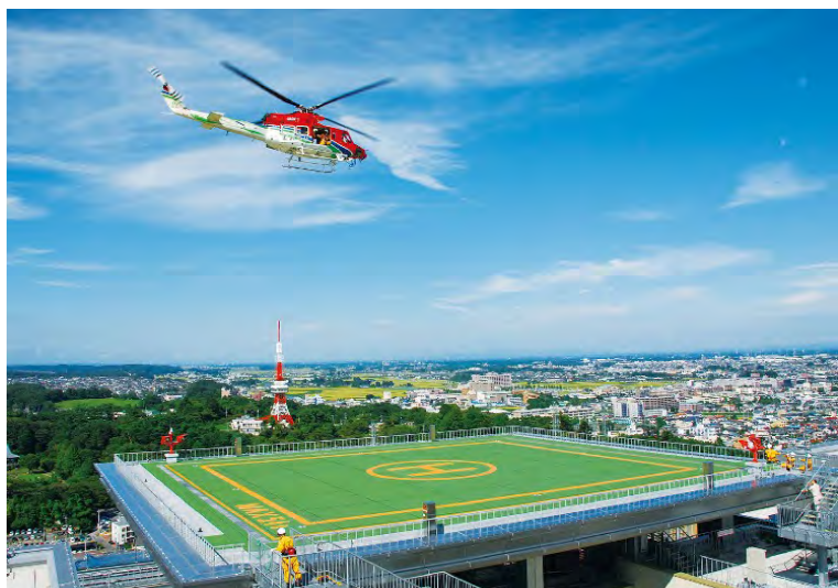
屋上ヘリポート
