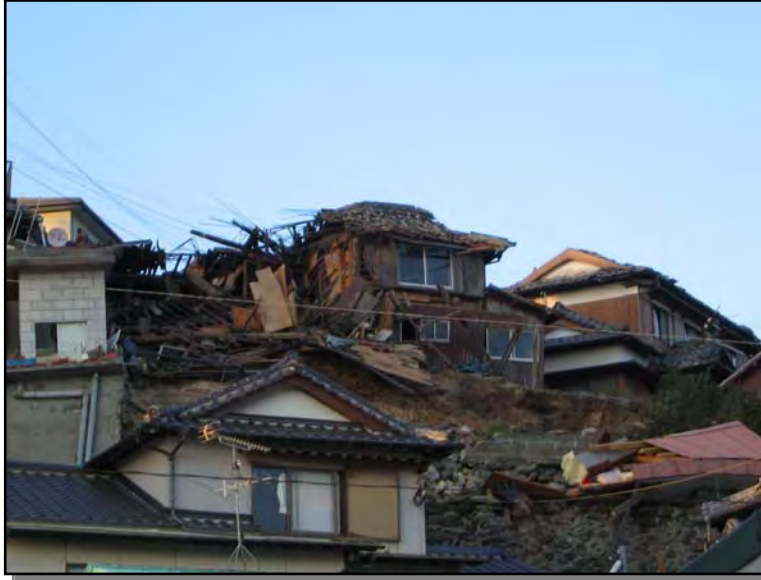
倒壊した家屋（平成17年 福岡県西方沖地震・玄海島）
