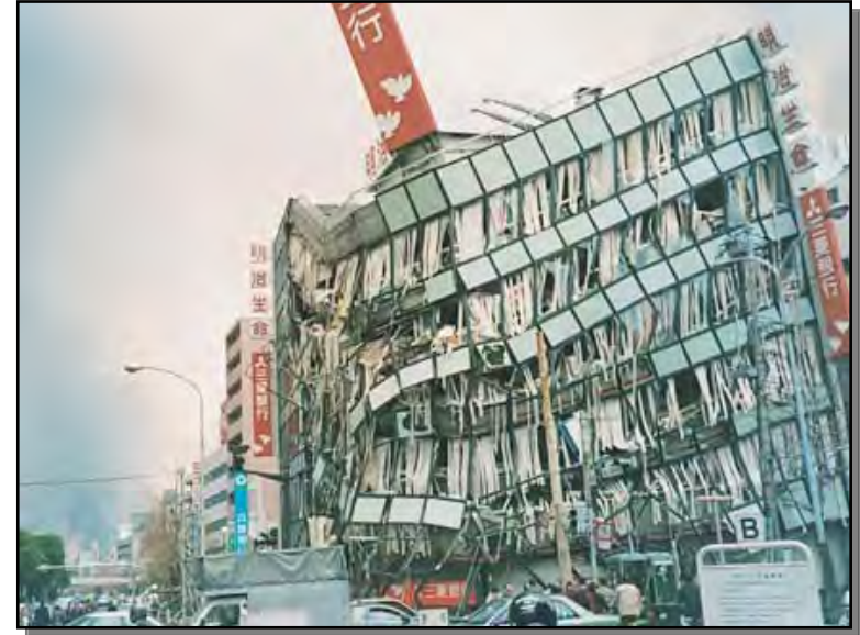
崩壊したビル（平成7年 阪神・淡路大震災）
