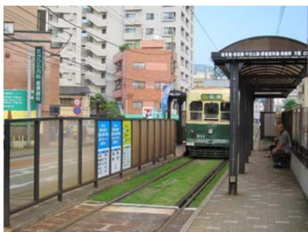
写真-17 路面電車の軌道敷の緑化 〈大浦天主堂下電停〉
