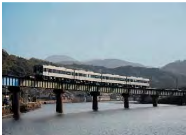
江迎川橋梁（傾斜・曲線付鉄橋）通過中の 松浦鉄道新型車両
