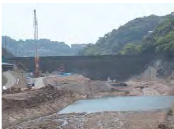
長崎水害緊急ダム（本河内ダム）の建設状況
