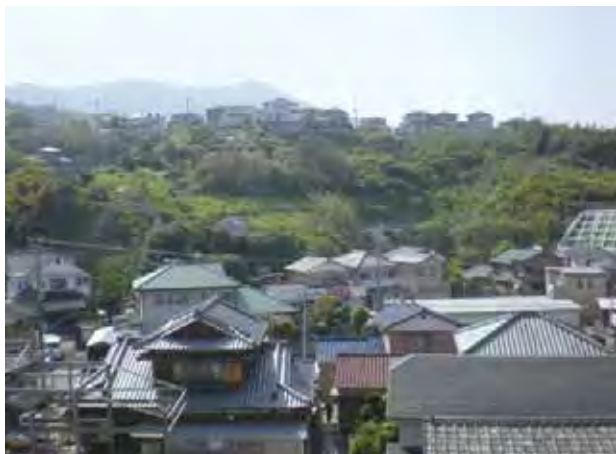
急傾斜地崩壊対策事業（毛井首）
