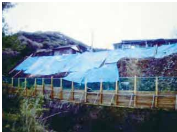
平成21年度防災工事状況 (吉福炭鉱2号ぼた山(佐世保市吉井町))
