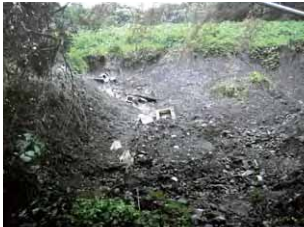
平成18年度被災状況 (丸尾炭鉱本坑ぼた山(佐世保市江迎町))
