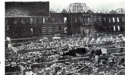
■原爆で消失した県庁舎
