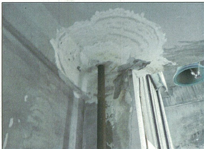
① (時計塔)『天井ひび割れ部分より雨水侵入』
