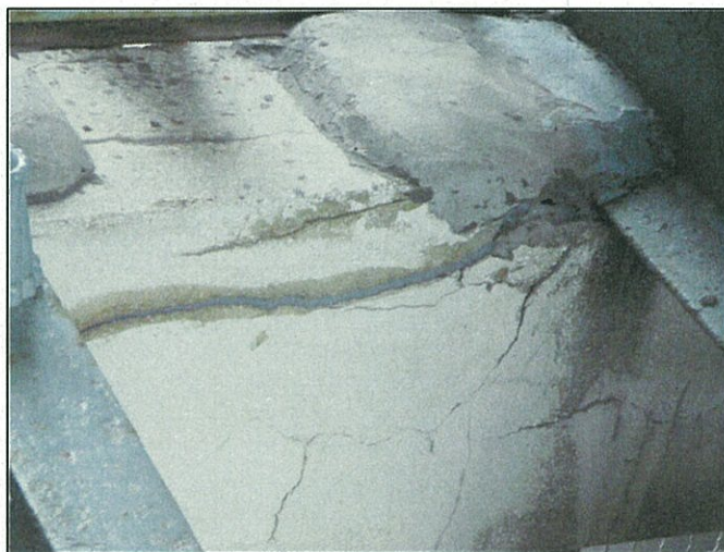
(時計塔)『打鐘装置支持部分亀裂』
