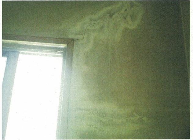
⑧ 3階階段踊り場 『庁舎内壁からの雨漏り』
