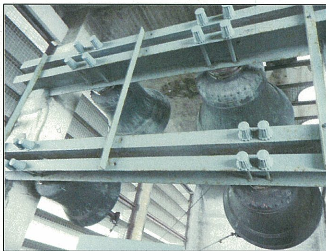
(時計塔)『打鐘装置支持部分亀裂』
