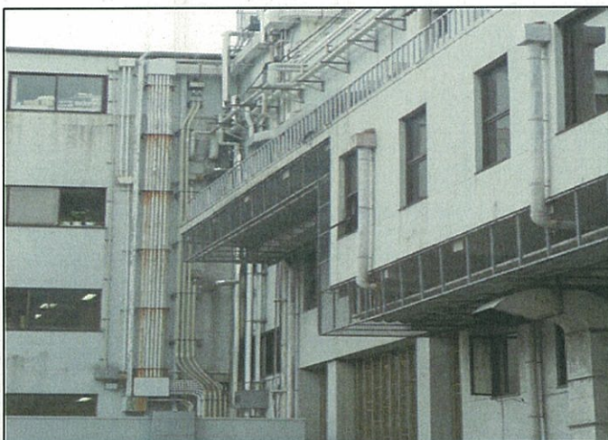
⑥ 設備配管等(改修状況)『老朽化』
