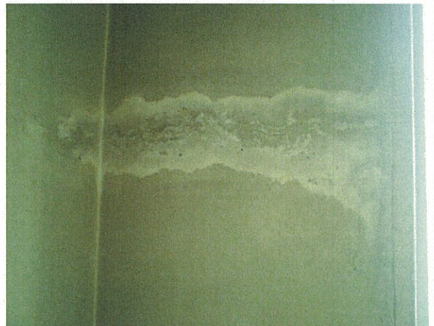
⑧ 3階階段踊り場 『庁舎内壁からの雨漏り』
