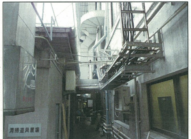
設備配管等(改修状況)『老朽化』
