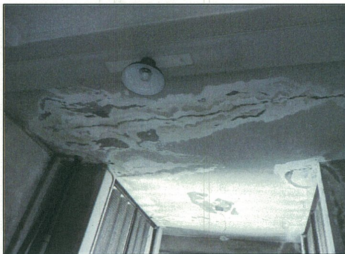
① (時計塔)『天井ひび割れ部分より雨水侵入』
