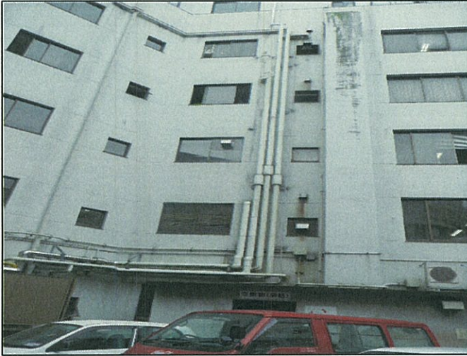
⑥ 設備配管等(改修状況)『老朽化』
