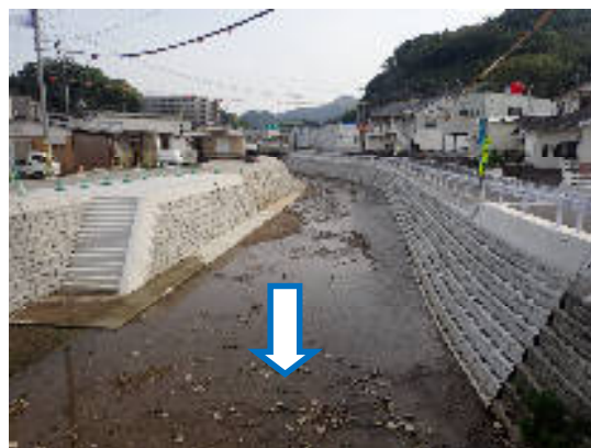
整備区間(完成)
