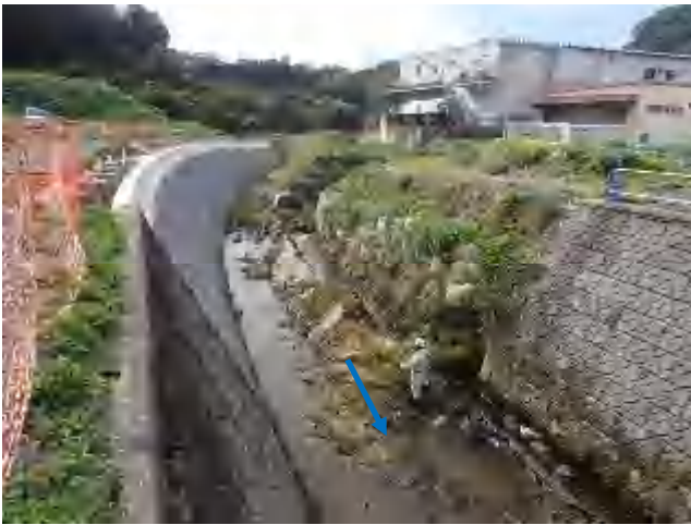
令和元年度整備区間(着工前)
