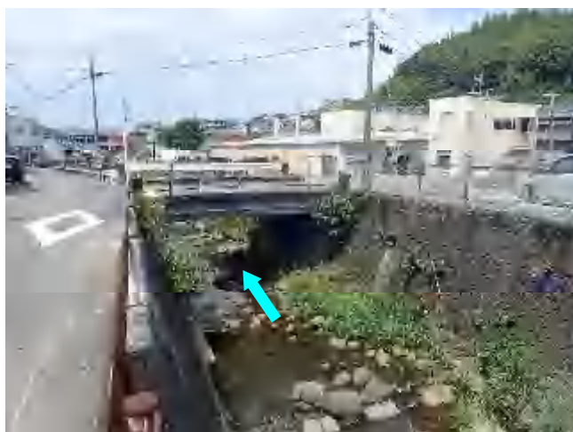
令和元年度整備区間 山徳橋(着工前)
