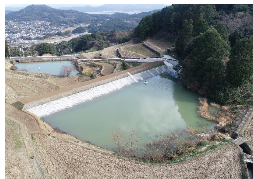
防災重点農業用ため池整備 (中堤ため池：松浦市)
