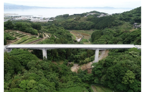
橋梁（川棚西部地区：川棚町） 下白大橋
