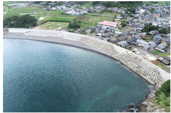
農地海岸施設整備 (簿山地区：平戸市)
