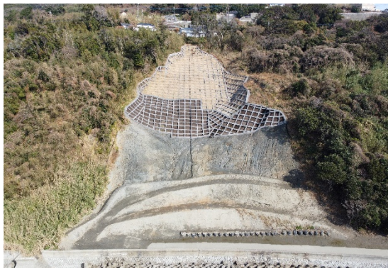
地すべり対策 実施中 (大野地区：長崎市)
