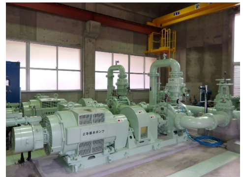
揚水ポンプの更新整備 (田平第二地区：平戸市)
