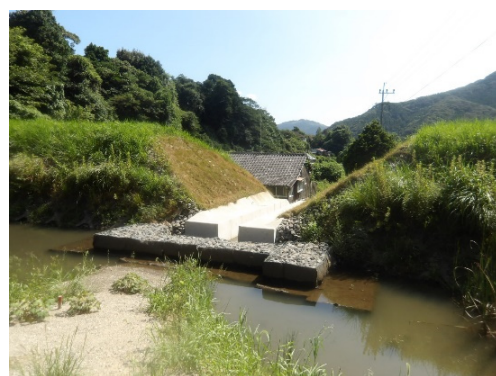
堤体開削によるため池廃止 (内裏池：佐世保市)
