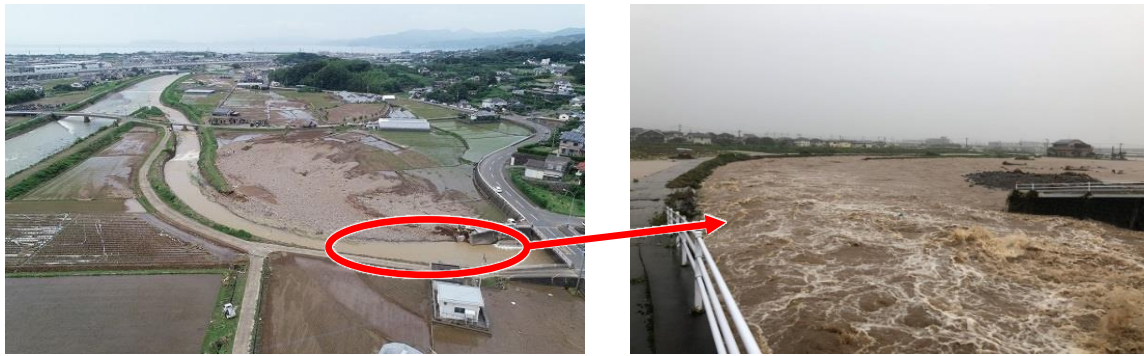
図 5-7 本県における豪雨災害（令和2年(2020年)7月豪雨 大村市） （堤防が一部決壊）
