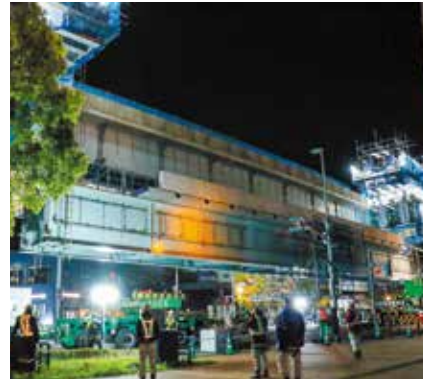
佐世保高架橋拡幅工事
