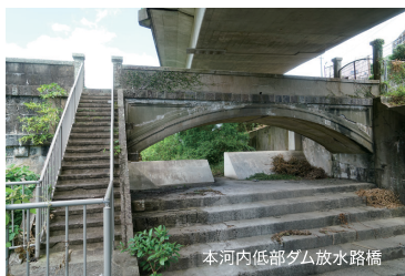
本河内低部ダム放水路橋
