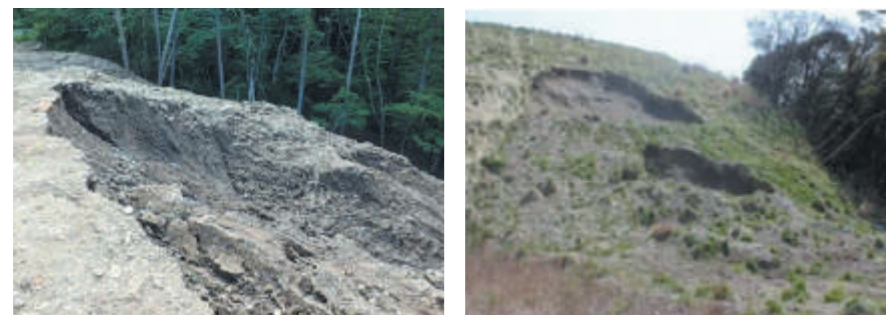
<危険な盛土、盛土移動のイメージ>
