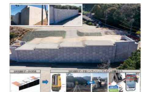
工事名 主要地方道長崎南環状線道路改良工事(大山町1工区) 施工業者 錦建設工業(株) 技術者 柿田 茂則
