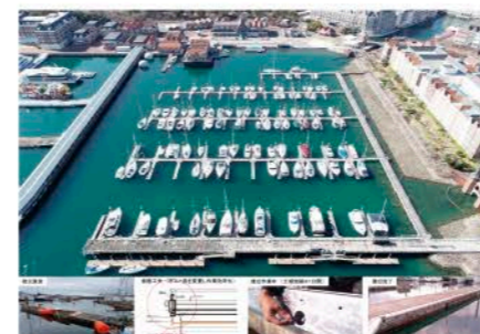
工事名 早岐港(HTB地区)災害復旧工事 施工業者 (株) なかはら 技術者 増永 政吉
