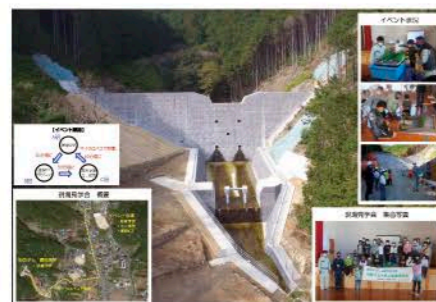
工事名 榎田川(イ)通常砂防工事 施工業者 豊建設(株) 技術者 築地 直樹
