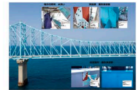
工事名 主要地方道平戸生月線橋梁補修工事(生月大橋塗装塗替8) 施工業者 池田工業・デバタ特定建設工事共同企業体 技術者 木戸川 健吾
