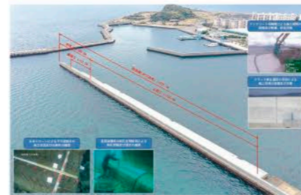
工事名 高島港改修工事 施工業者 (株) 三基 技術者 朝長 芳憲
