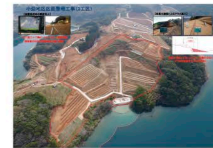
工事名 小迎地区区画整理工事(3工区) 施工業者 面高建設(株) 技術者 平野 和浩
