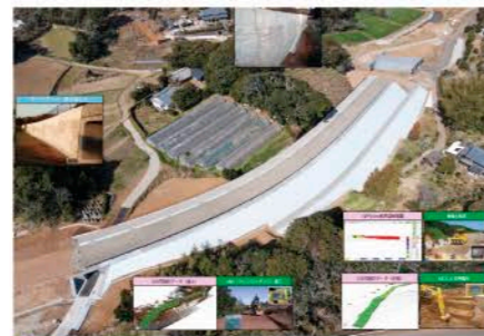
工事名 主要地方道平戸田平線道路改良工事(田平5工区) 施工業者 大坪建設(株) 技術者 橋本 高繁
