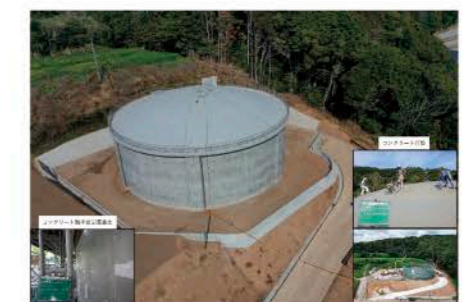
工事名 空池原地区貯水施設工事 施工業者 柴崎建設(株) 技術者 中島 真一郎
