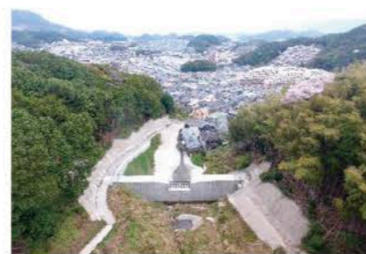
土石流対策の砂防ダム（長崎市）
