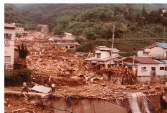
川平地区の土石流被災（長崎市）
