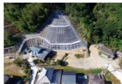
がけ崩れ対策施設（佐世保市）
