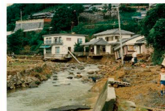
東長崎地区中尾川の被災（長崎市）
