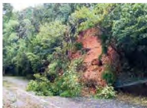
令和2年台風10号により被災した佐尾港線(新上五島町奈良尾郷)
