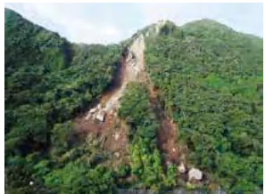
令和2年7月豪雨により被災した平戸生月線(平戸市主師町)
