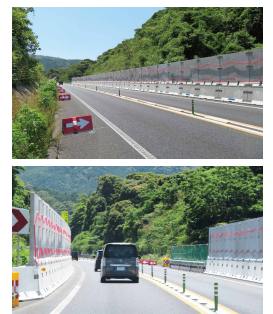
防護柵設置状況 (佐世保市小野町付近)
