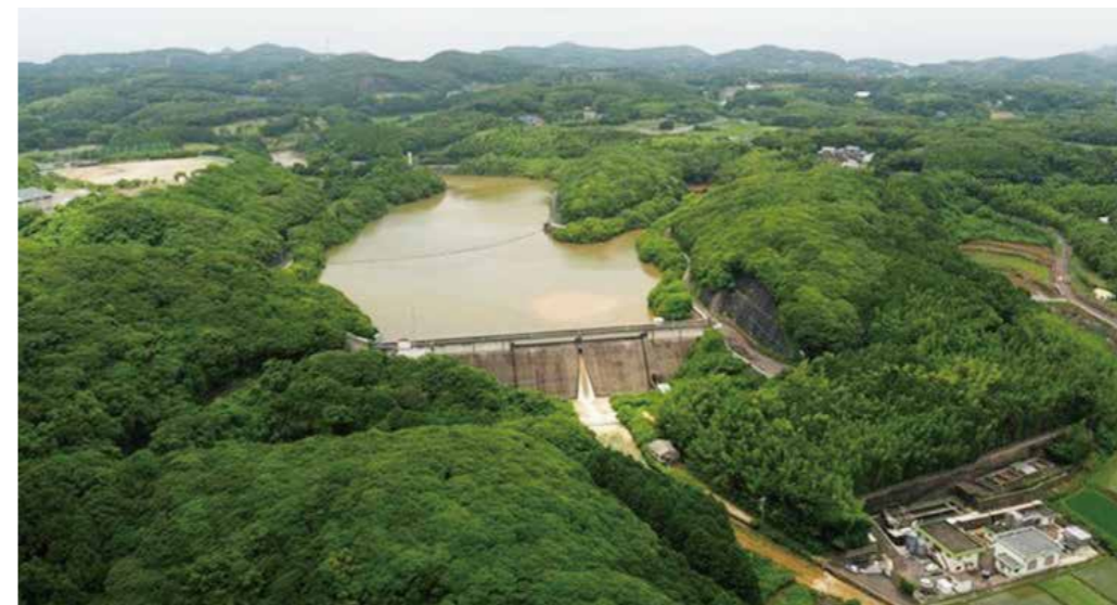
平成29年6月30日 九州北部豪雨 洪水調節により下流の洪水災害を防止した勝本ダム(壱岐市) 提供:九州地方整備局
