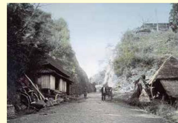
開通直後の日見峠切通し
