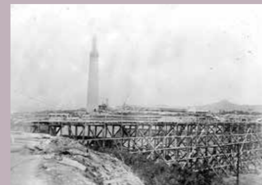
針尾無線送信所無線塔*(1号、2号、3号塔 大正11年(1922)完成)基部からの高さ:137.2m、基部外径:12.2m、頂部外径:3.1m、基部厚さ:0.76m。
