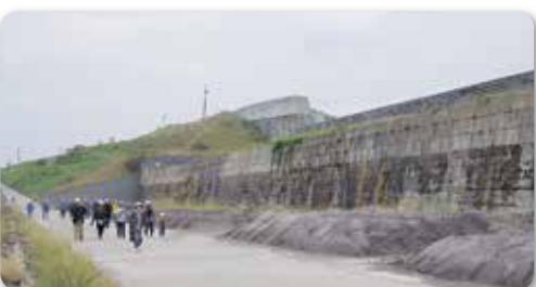
水無川2号砂防堰堤
