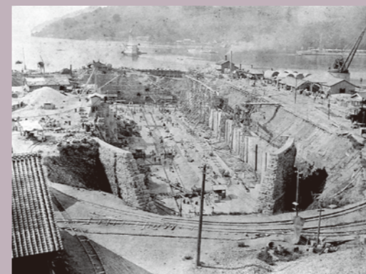
第1船渠(現第5ドック)*(明治27年(1894)起工、明治28年(1895)完成予定崩壊、明治34年(1901)完成)長さ:131m、幅:22.8m、深さ:10.05m。
