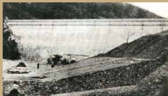
本河内低部ダム (疎石コンクリート造重カダム、高さ22.71m、長さ115.15m)※
