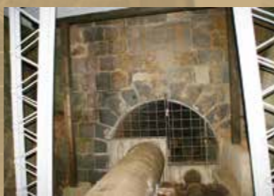
一ノ瀬隧道(本河内低部ダムから鳴滝へ349m、本河内低部ダム側坑門)
