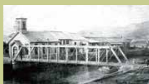
出島新橋（ブラットラス形式、木鉄混交橋、明治21年（1888）架設）（活水学院所蔵）
