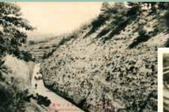
長崎から雲仙・島原・天草・熊本に行くために、茂木港は重要であった。茂木新道の途中にある大規模な田上切通し。（個人蔵）
