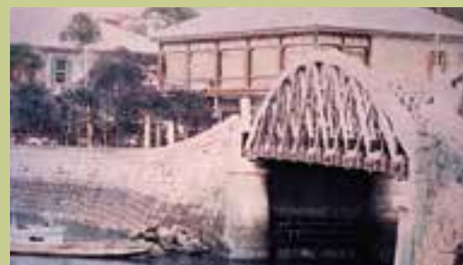
松ヶ枝橋（ポストリングトラス形式、木鉄混交橋、明治22年（1889）架設）（個人蔵）
