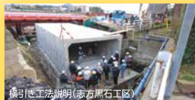
横引き工法説明(志方黒石工区)
