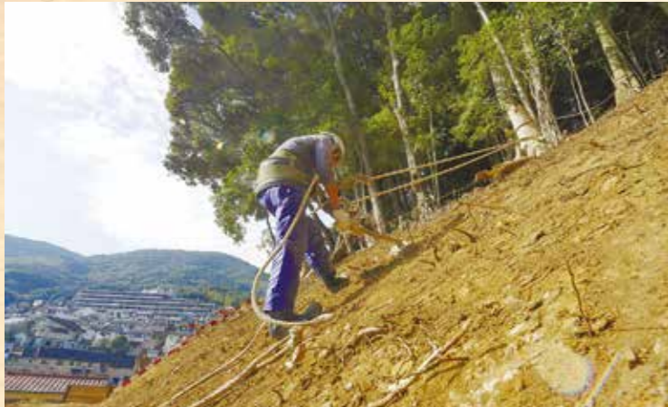
こうしてロープで吊られながら鍬のような用具を使い木の根を除去していた(石坂(2)地区)。
