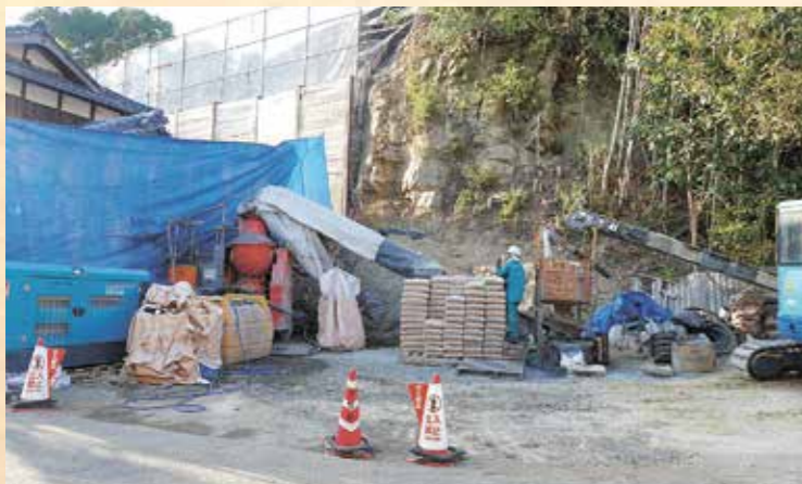
コンクリートを送っている場所。この現場はこういうスペースが近くに取れたことが幸運だったようだ(大和(8)地区)。
