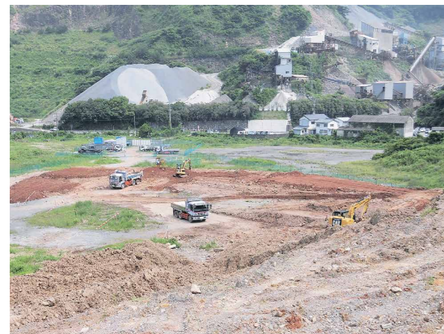
重機等による土工作業の進捗状況
