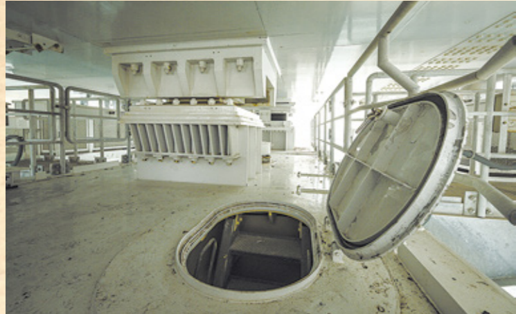
中央にあるのが今回交換する支承。右側はメンテナンス用入口。
