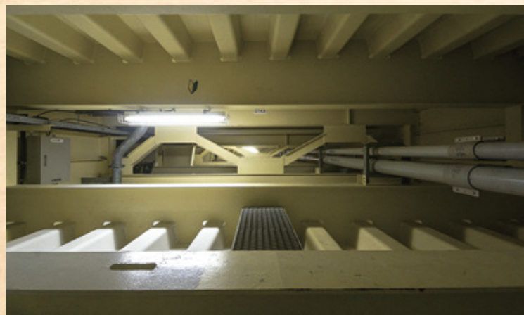
橋の内部。大島大橋は水道や電話線などのインフラも通っている。
