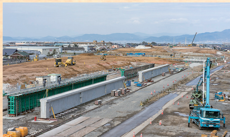
④大村車両基地(手前は製作中の橋桁) この現場では、トンネル掘削で排出された土を利用し盛土されている。
