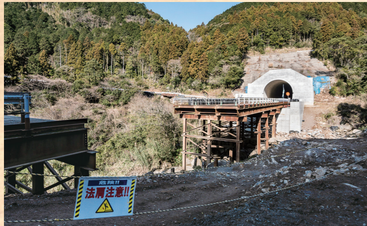
しおつるがわ ③彼杵トンネルと塩鶴川橋りょう建設予定地 線路は山々を貫き、谷を越え伸びていく。
