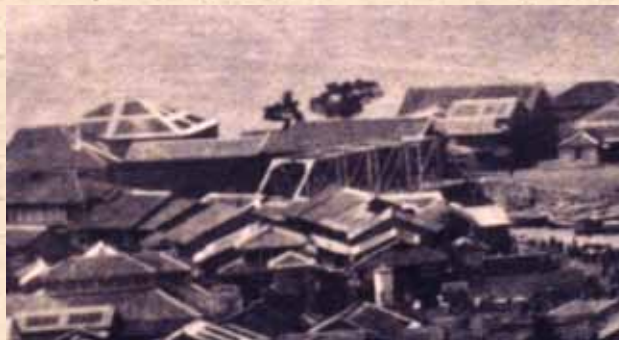
架設直後の新川口橋(橋の向こうは出島)
