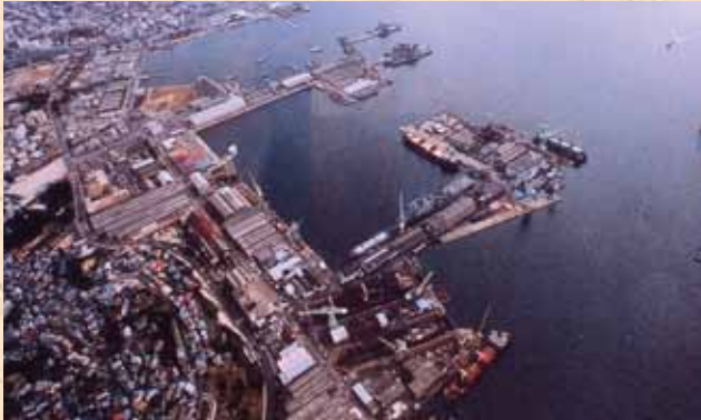
立神係船池(修理艦船繫留所)
