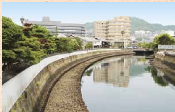
中島川変流工事跡
