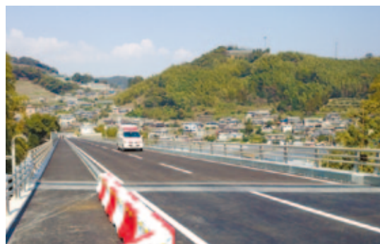
飯香浦工区【片峰橋】(主要地方道野母崎宿線) 長崎市
