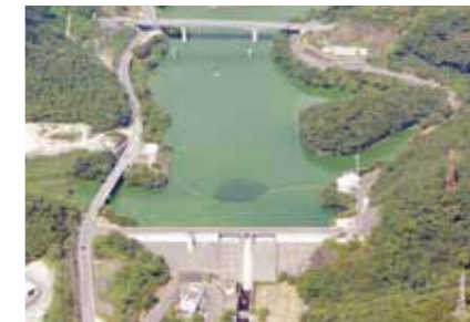
中尾ダム(平成12年完成) (長崎市田中町に新設)
