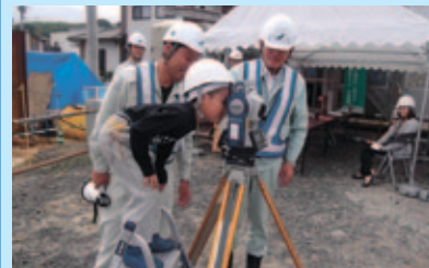
実際に工事現場で使用している測量機器を使って、構造物の角度を測りました。
